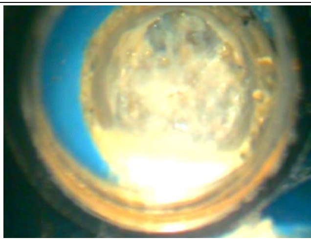
foto 12: Otvor po cementaci
