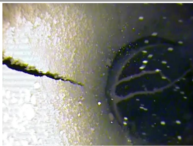
foto 2: Pozvolný přechod průměru pažnic v hloubce 33 m.
