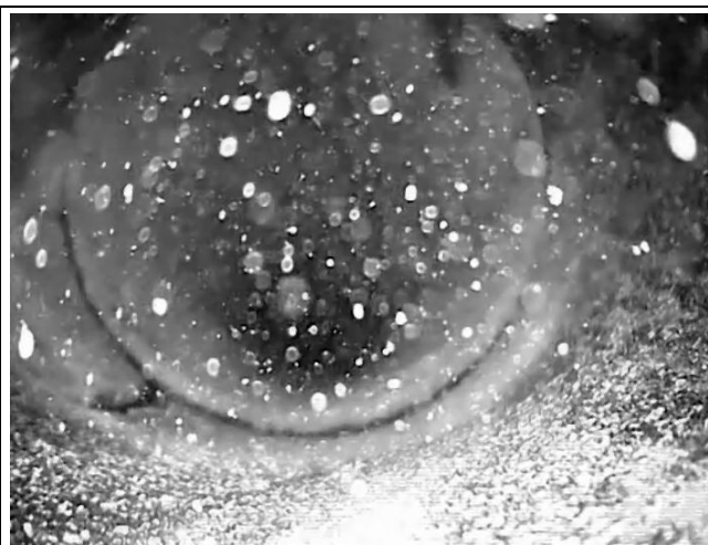
foto 9: Trhacími pracemi přetržený spoj pažnic ve 40 m. Vlevo dole prostřelená perforace.
